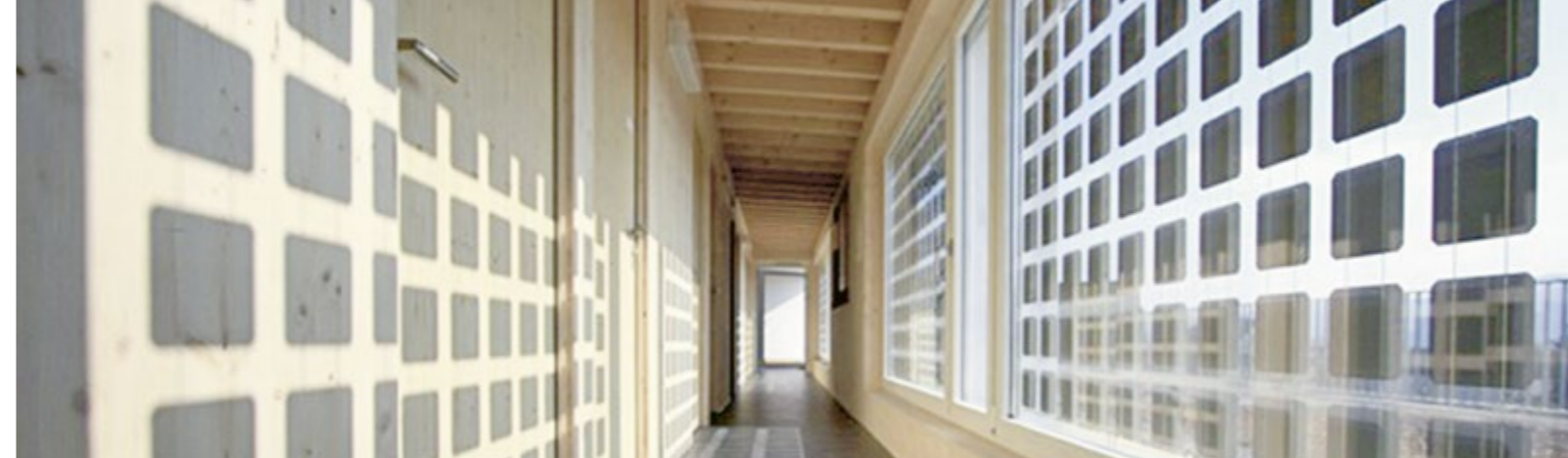
Bild: Fassaden PV-Module für die Minergie-P-Modernisierung eines Mehrfamilienhauses in Wettingen | © Miloni Solar AG, Wettingen
