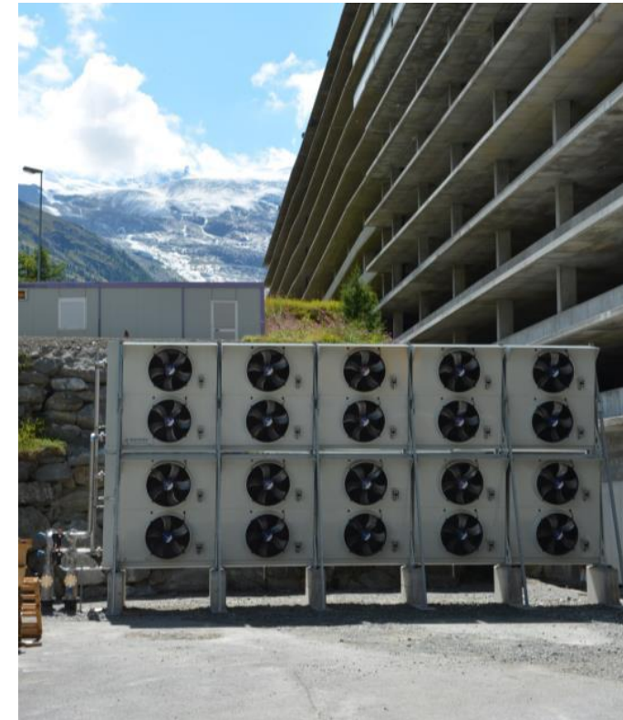
Ausseneinheit Wärmepumpe
