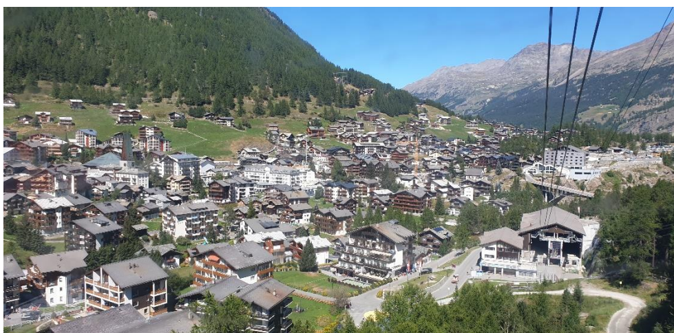
Abb.7: Sicht von Nordwest auf das Siedlungsgebiet
